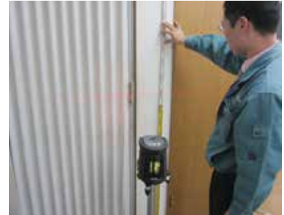
建物内部レベル測定
