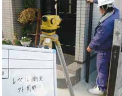
建物外部レベル測定
