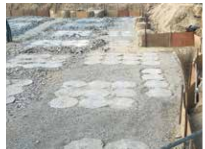
掘削後出来形
