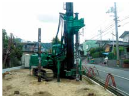
ガイアパイル施工
