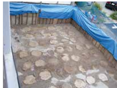
掘削後出来形
