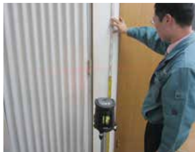
建物内部レベル測定
