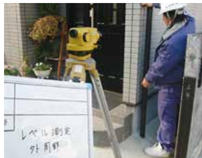
建物外部レベル測定
