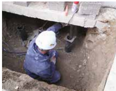
アンダーピーニング工法
