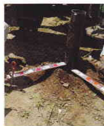
⑥ 施工完了（杭頭ズレ確認）
