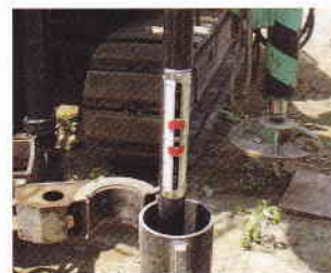
\pm\alpha (2) スライドウェイト計測（支持地盤の確認）
