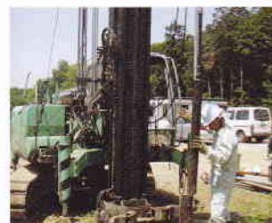
\pm\alpha (1) 杭先端部モンケン落下
